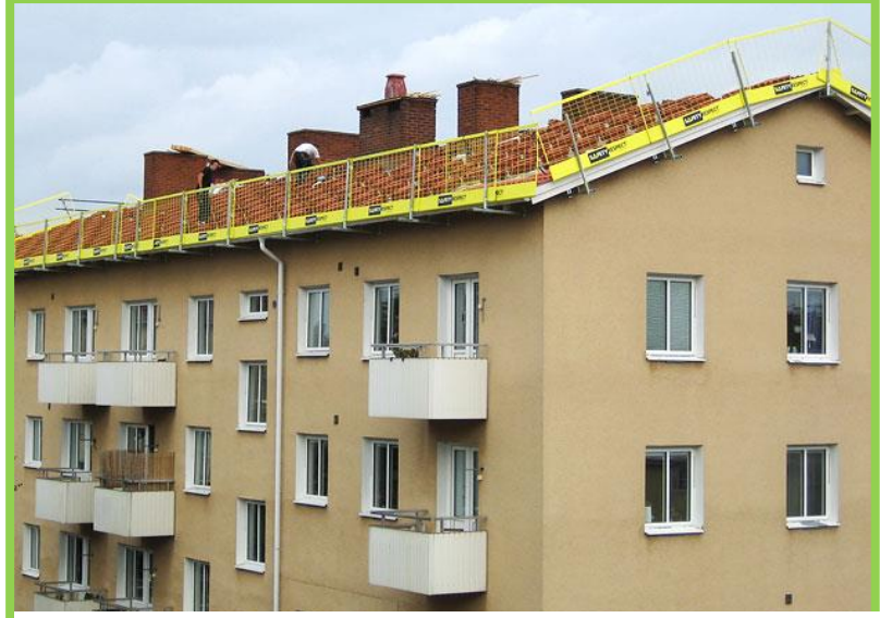
Şekil 5.7. Çatı çalışmasında düşmeye karşı koruma [34]
