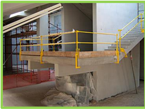
Şekil 5.11. Kat merdivenlerinde düşmeye karşı koruma [37]
