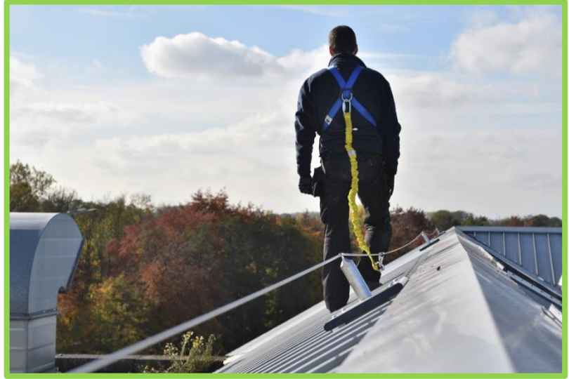
Şekil 5.8. Yaşam hattı ile düşmeye karşı koruma [35]
