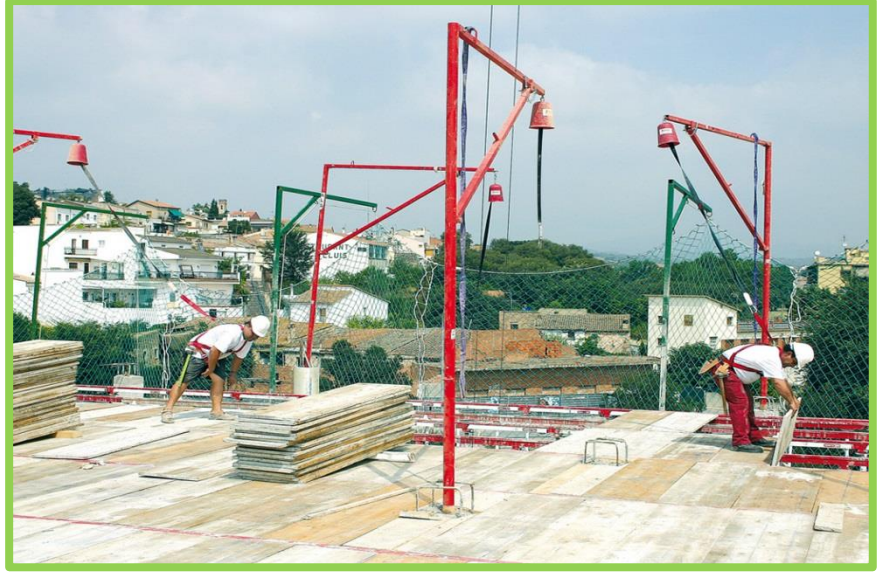
Şekil 5.4. İnşaat kalıp çalışmasında düşmeye karşı koruma [31]
